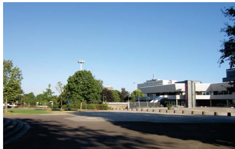
Ergänzende Baukörper auch im Umfeld des Forum
