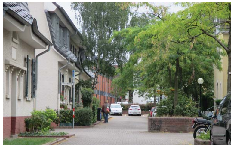
Altbausubstanz Kolonie II Anna, Denkmalbereich mit besonderen Auflagen
