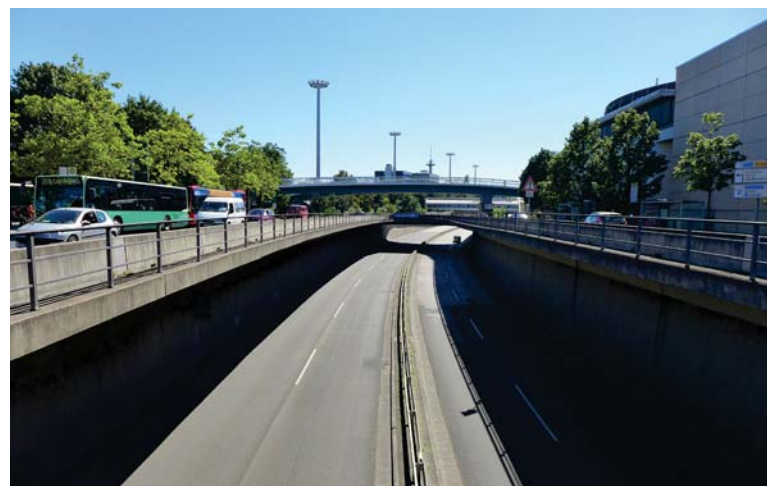
B8 mit Y-Brücke für Fußgänger und Radfahrer
