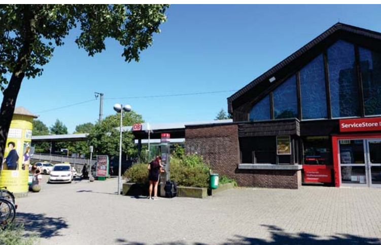
Eingang Bahnhof mit angrenzenden Gleisanlagen
