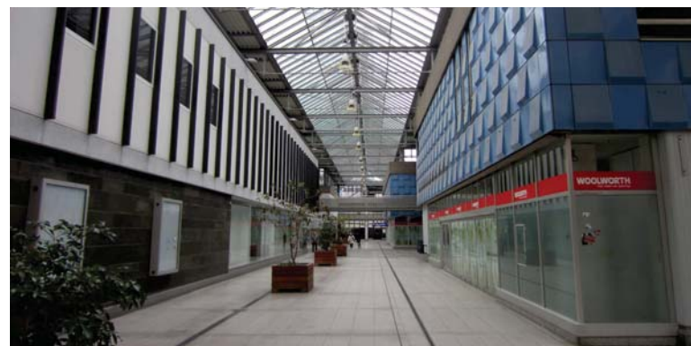
Leerstehende Bausubstanz im City C
