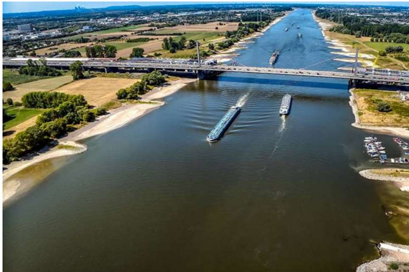
Kaum noch Wasser im Rhein: die schmale Fahrrinne an der Rheinbrücke in Leverkusen. Foto: Matzerath, Ralph (m+)
