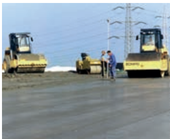
Die Altablagerungsfläche wurde bei der Sicherung mit mehreren Schichten versiegelt. Die Oberfläche wurde genau ausgemessen, um darauf anschließend eine Kunststoffdichtungsbahn zu verlegen.
