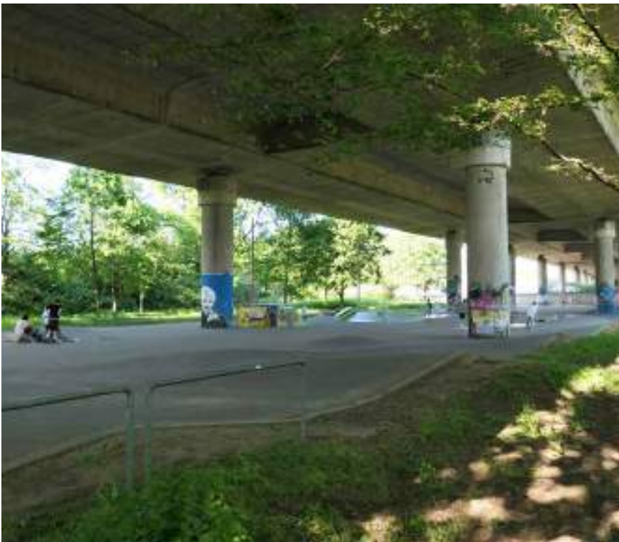
Abb.: Skatepark Stelzenbrücke (Q: s+w plus)
