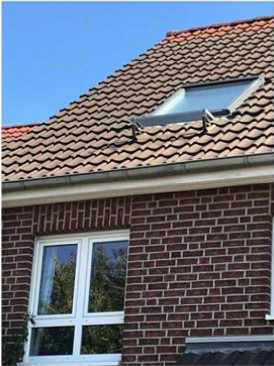
Abbildung 8 Austritt mit einer Stufe
