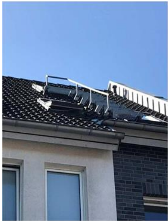
Abbildung 11 Austritt mit mehr als zwei Stufen und Festhaltemöglichkeit
