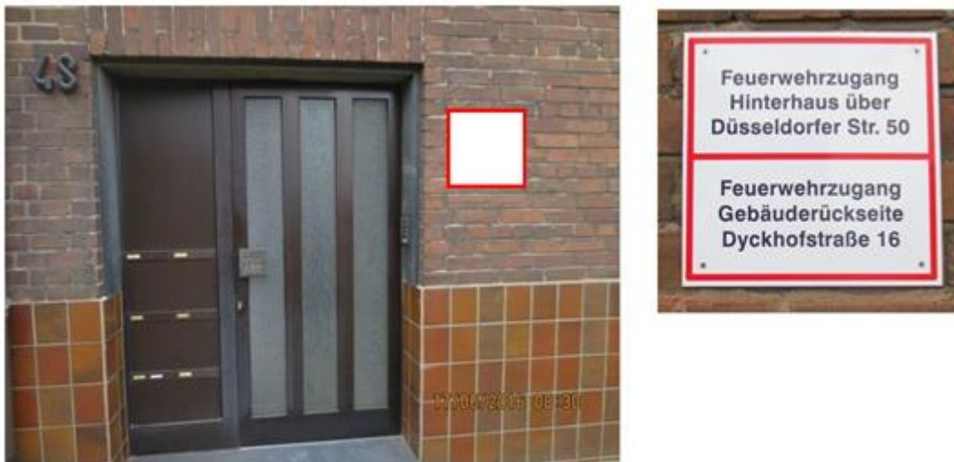
Abbildung 4 Beschilderung Feuerwehrezugang Nahaufnahme
